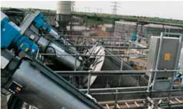
Varios equipos en paralelo; 1 x tamaño 2400 ( Q_{max} = 1600 l/s), 2 x tamaño 1800 (2 x Q_{max} = 900 l/s), paso de tamiz e = 6 mm
