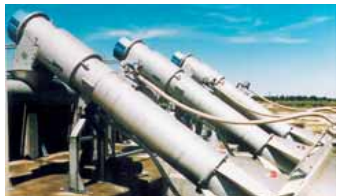
Bahía Blanca, Argentina: ROTAMAT® Ro 2 \varnothing 2600 mm, colocando varios equipos en paralelo, se puede tamizar cualquier caudal
