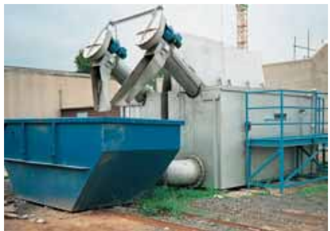
Versión de colocación en contenedor, 2 equipos en paralelo, protegidos contra heladas hasta -25°
