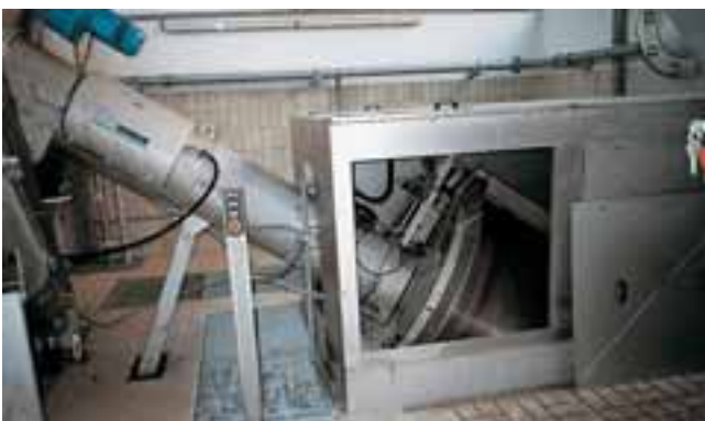
Tamiz ROTAMAT® Ro 2, tamaño 2000 ( Q_{max} = 900 l/s), paso de tamiz 3 mm, sin tamiz de gruesos previo, colocado directamente en el canal de entrada
