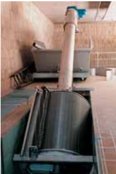
Izquierda: Flujo obligado desde dentro del tambor hacia fuera; los residuos de desbaste no pueden llegar a la zona de aguas limpias detrás del tamiz
