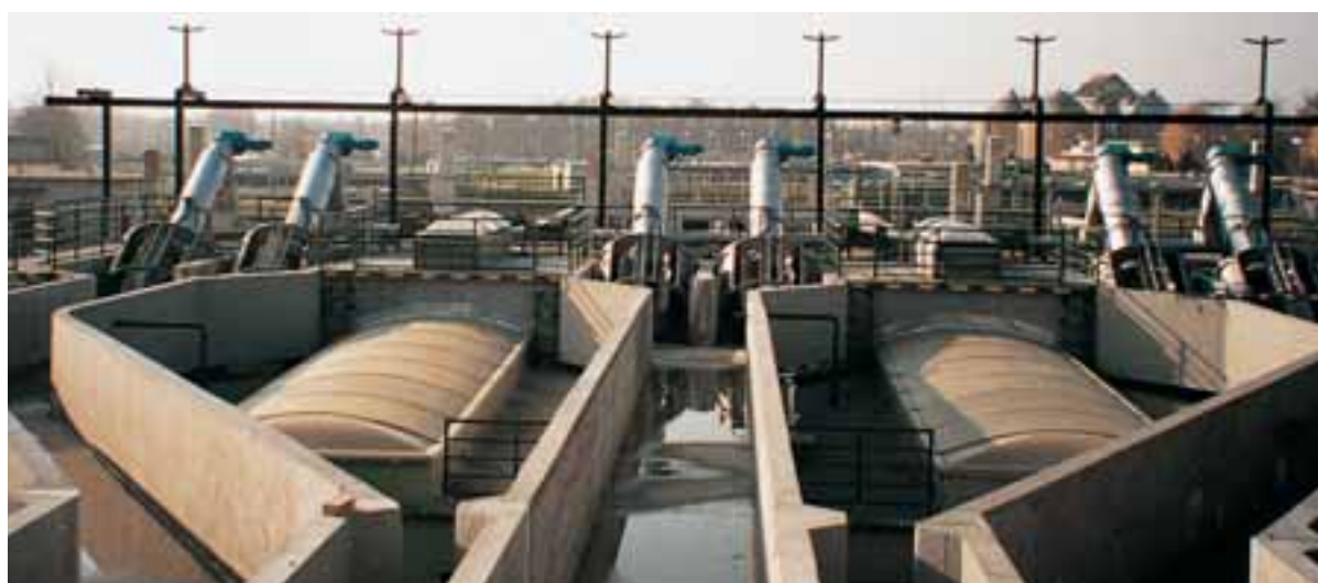
EDAR Budapest (Hungría): 6 Tamices ROTAMAT® Ro 1, diámetro = 2000 mm, paso = 10 mm, Q_{max} = 6 \times 2500 \text{ m}^3/\text{h} , instalación directamente en el canal, modelo protegido contra heladas.
