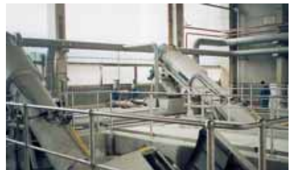
Tamiz ROTAMAT® Ro 1, \varnothing 3000\text{ mm} , colocado directamente en el canal, poniendo varios equipos en paralelo cualquier caudal puede ser tamizado
