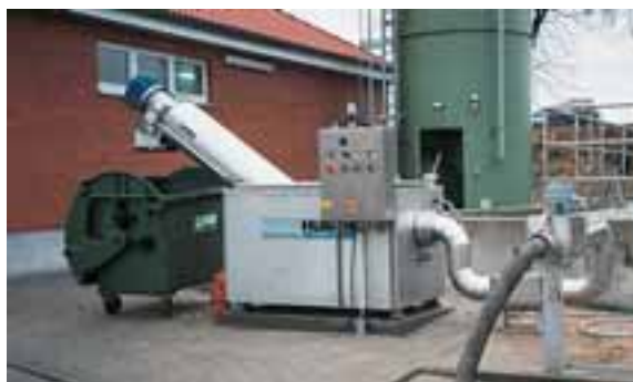
Tamiz ROTAMAT® en contenedor, modelo protegido contra heladas, en este caso como planta de recepción de lodos fecales
