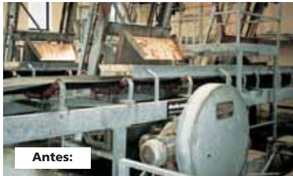
EDAR Traismauer (Austria): Reforma de un sistema de desbaste, sustitución de 2 rejillas gruesas ( e = 50\text{ mm} ) y 2 tamices de finos ( e = 25\text{ mm} ) por ...
