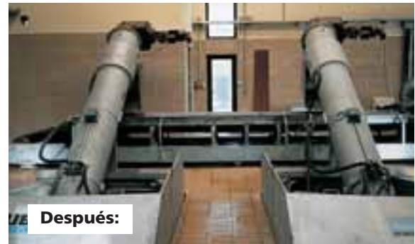
... 2 tamices ROTAMAT® Ro 1 con e = 15\text{ mm} y Q_{\max} = 2 \times 1500\text{ l/s}
