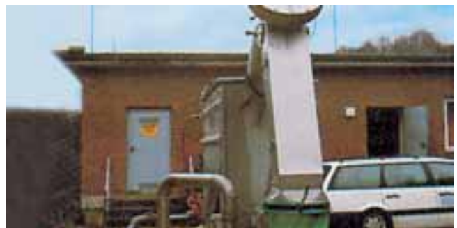
Sistema de ensacado del residuo
