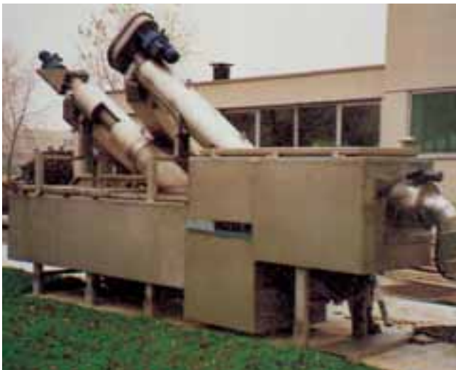
Planta de tamizado de fangos HUBER ROTAMAT® con desarenador y clasificador de arenas.
