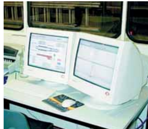
Se registran todos los parámetros de funcionamiento
