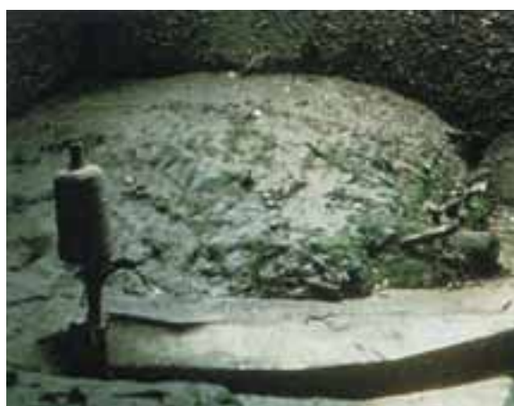
Sedimentos en tanques sin sistema automático de limpieza
