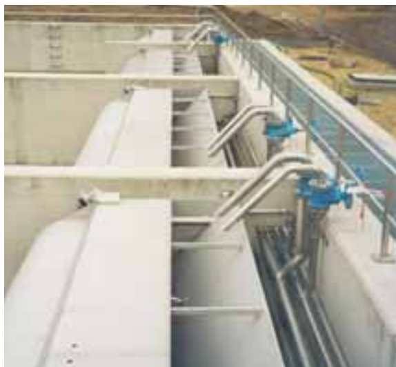
Volquetes con sistema de suministro de agua
