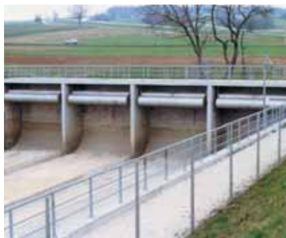
Volquetes suspendidos en una pared lateral de un tanque rectangular.
