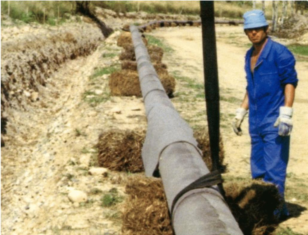
La manta-antirroca **ROCAMAN** se utiliza para la protección mecánica de tuberías enterradas. Protege mecánicamente el revestimiento de la tubería contra rayaduras, golpes, impactos, etc., producidos durante la instalación de la misma.
