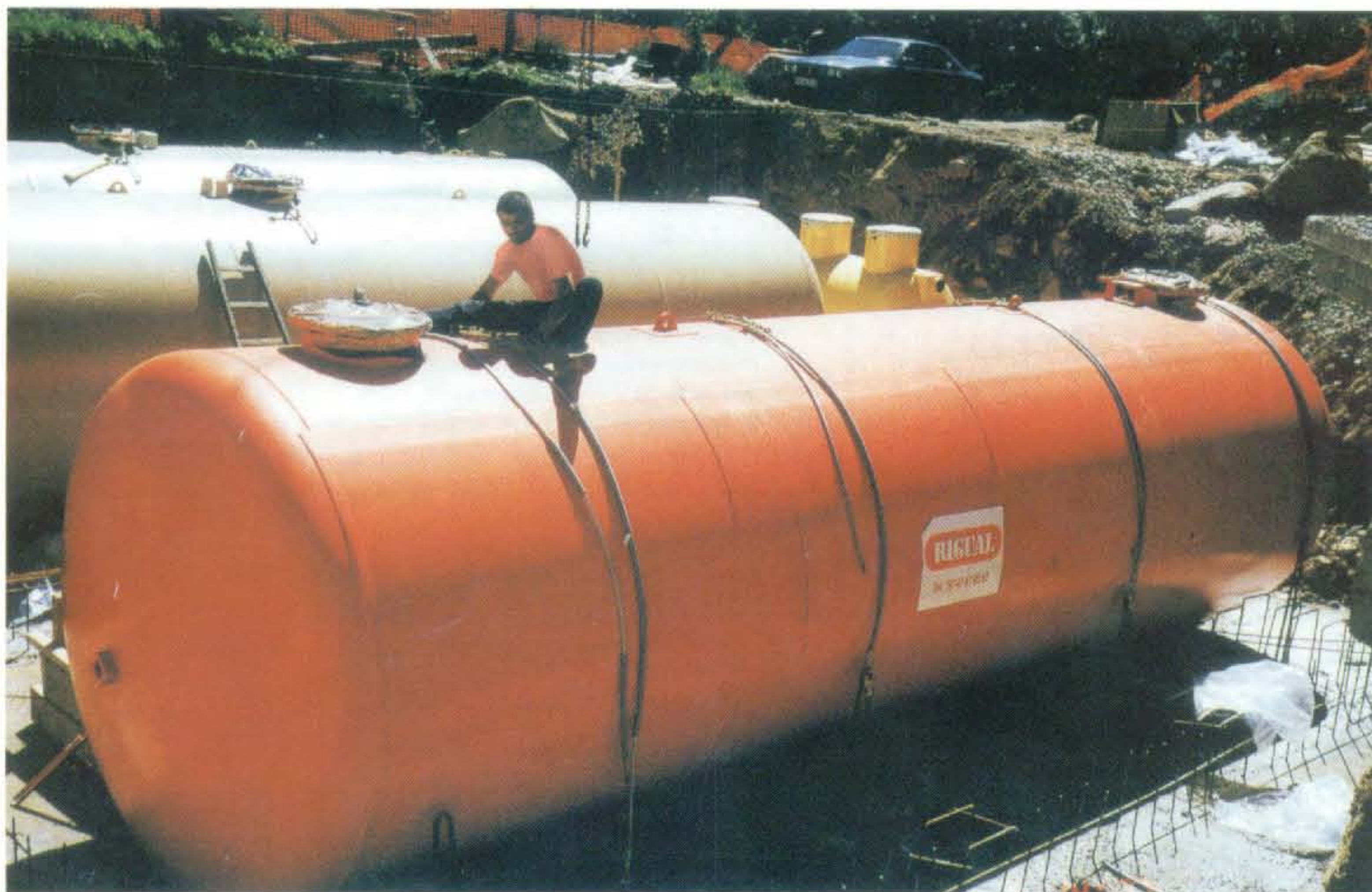
DEPOSITO ENTERRADO DOBLE PARED
