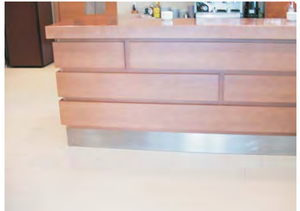
Zona bar muy transitada, pavimento modelo Belvedere 300 x 600 mm
