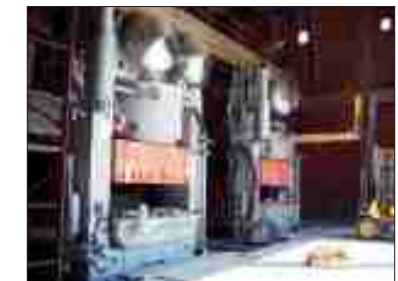
Montaje de las dos prensas nuevas.
