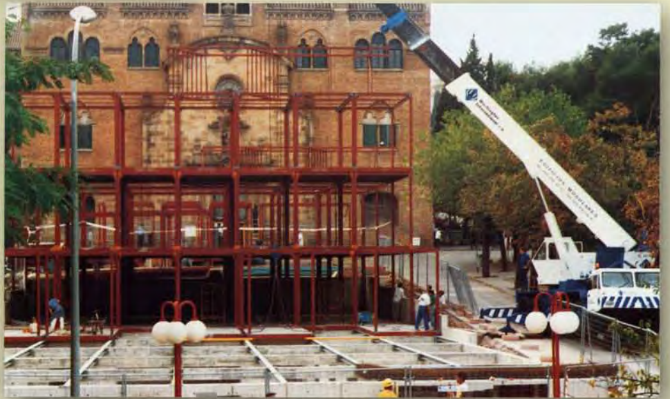
Comienzo montaje estructura
