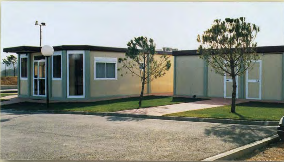
Complejo tratamiento residuos
