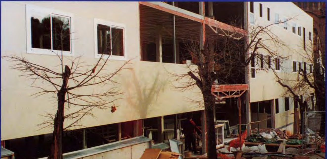
Contrucción anexo hospitalario
