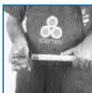
Introducir el tubo en el accesorio
