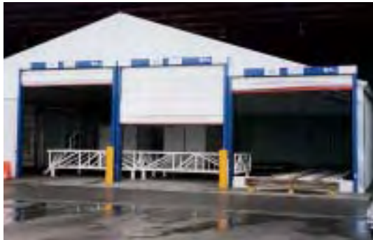
Puertas y portales manuales o automáticos
