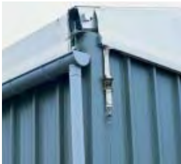
Canalón y bajantes
