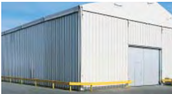
Pretil de protección
