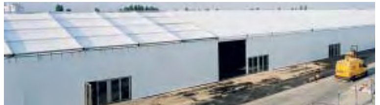
Aislamiento térmico y acústico(doble techo, cerramientos aislantes)
