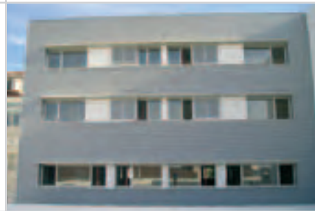
Ocultación de bajantes pluviales (pudiendo mantener la accesibilidad y el registro) y otros defectos.
