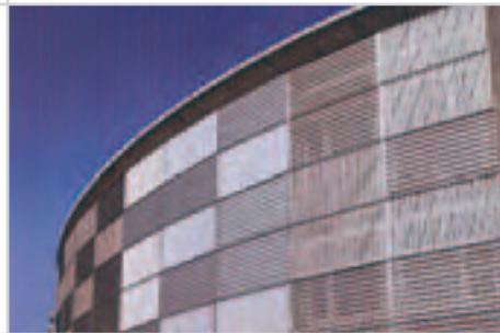
Personalización de los motivos arquitectónicos gracias a la combinación de varios tipos de revestimientos y materiales, utilizando perfiles lisos y microperforados.
