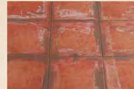
Efectuar el relleno o sellado de las juntas utilizando una llana de goma dura, sin dejar vacíos los desniveles.
