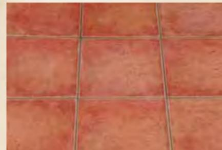
**Limpieza de las juntas:** Respetando los tiempos del fabricante, limpiar con un trapo de hilo húmedo toda la superficie, incluido el rejuntado. Al secar puede quedar una capa o velo en toda la superficie, que puede ser limpiada con agua. No dejar pasar mucho tiempo para limpiar los restos de juntas.
