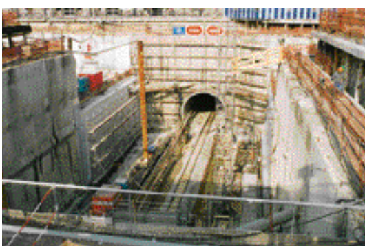
Galería comercial subterránea - Estación de Estrasburgo
