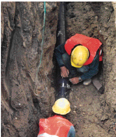
Redes SMU® Plus instaladas en soleras
