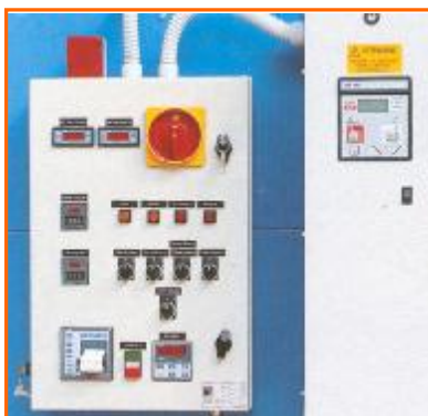
Detalle equipo de mando del humidificador FUN 9000
