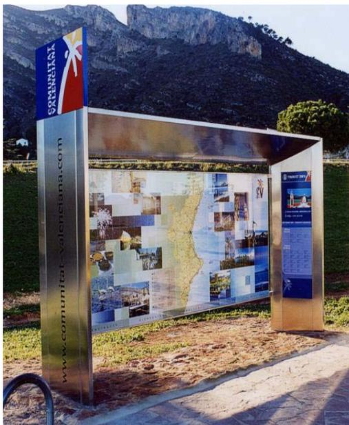
Marquesina de forma rectangular, compuesta de estructura interior en perfilera de acero, forrada exteriormente en chapa de acero inoxidable conformada. Con rotulación en todas las caras.
