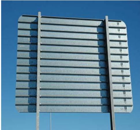
Los carteles laterales situados fuera del arcén de las carreteras, se sustentan mediante viguetas, generalmente de tipo IPN. Estas viguetas pueden fijarse al terreno mediante empotramiento en macizo de hormigón, o mediante placa de apoyo soldada en su base y atornillada a los pernos de anclaje de la cimentación.
