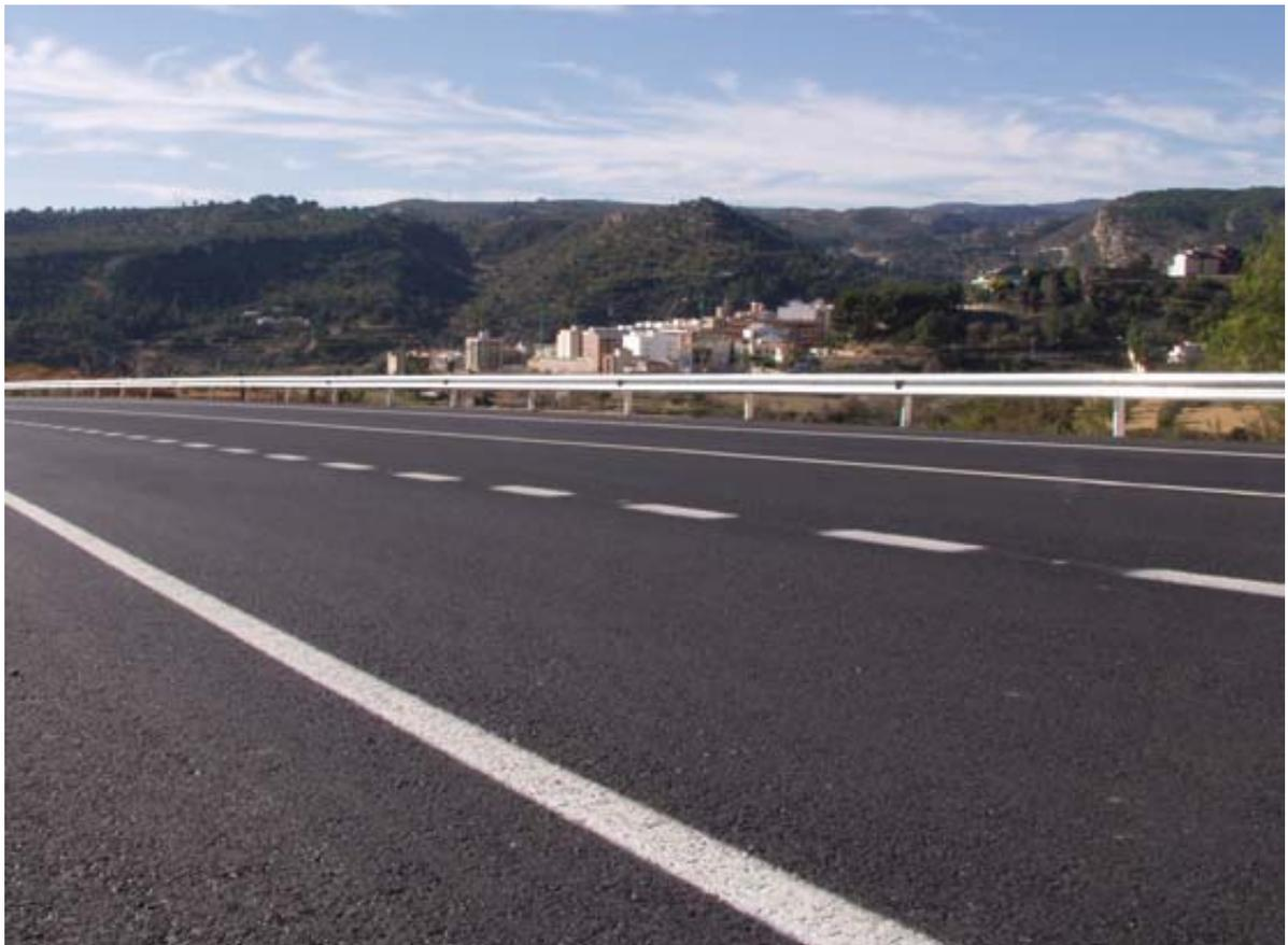
La señalización horizontal es un elemento básico de la seguridad vial. Su función resulta particularmente importante en condiciones de luminosidad reducida (climatología adversa y en horas nocturnas). Se emplean pinturas de gran calidad que sean visibles y mantengan sus propiedades de luminosidad y reflectancia durante largo tiempo, estando homologadas por el Ministerio de Fomento.
