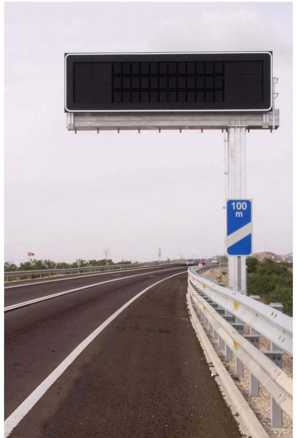
Los soportes y dinteles de las estructuras de aluminio se construyen mediante la unión por soldadura de perfiles de extrusión y chapas de distintos espesores, con distribución de rigidizadores internos.
