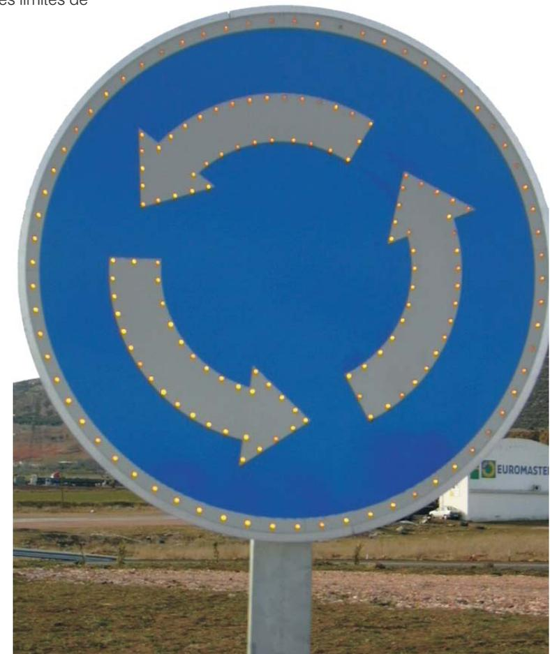
Diferentes señales reforzadas con leds. ►
