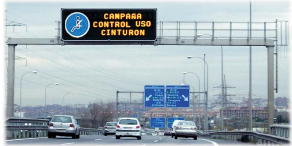
Sistemas de señalización electrónica que mediante LED's de alta resolución con última tecnología (incluso 64x64), ofrece a los conductores información dinámica y en tiempo real tanto del estado del tráfico e incidencias de cualquier tipo en la carretera (accidentes, corte de carril, obras, etc...) como de las condiciones meteorológicas.
