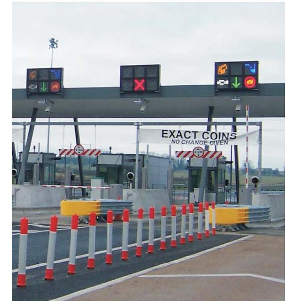
Son sistemas de señalización electrónica que mediante LED's de alta resolución con última tecnología, se iluminan cuando ocurren unas determinadas circunstancias.
