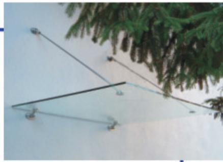
Sistema de marquesina de vidrio estructural PUNTpart, construida con vidrio laminado de seguridad, accesorios y rótulas de acero inoxidable AISI-316. Sistema estable con los componentes de vidrio rotos.
