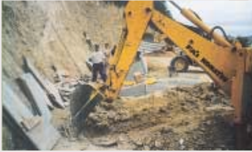
Excavación de zapatas
