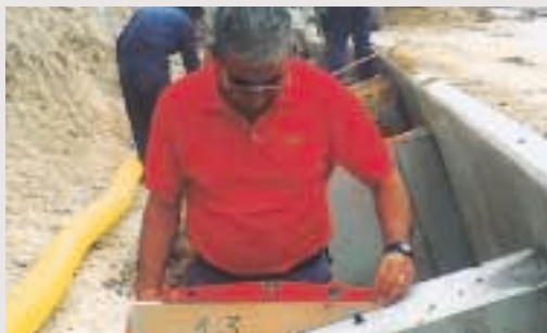
Nivelado de pedestales
