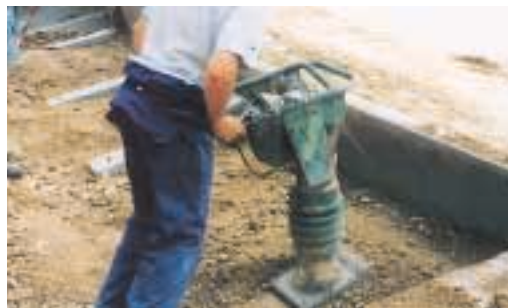
Compactado entre pedestales
