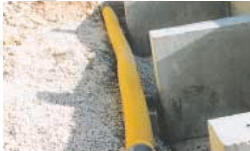
Colocación del dren
