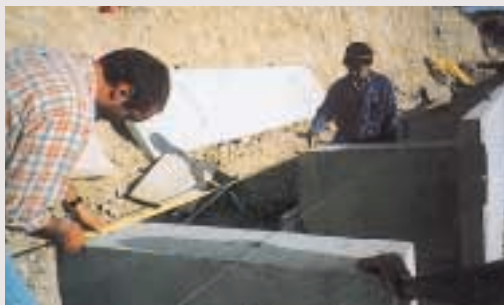
Comprobación de ejes de pedestales
