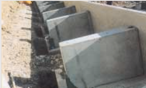
Colocado de pedestales y zócalos
