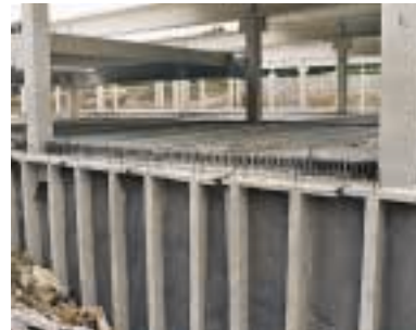
Forjados apoyando en Muro
