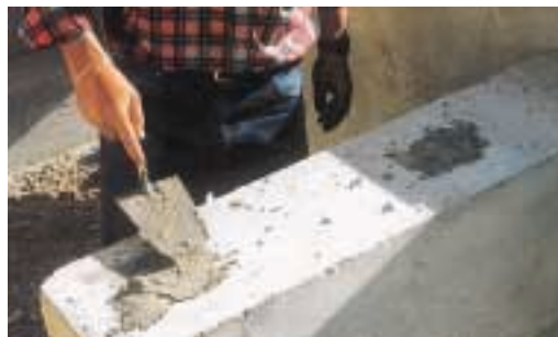
Preparación de la superficie de asiento de los módulos con mortero
