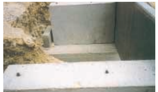
Colocado de espárragos en pedestales para espera del módulo de Evergreen
