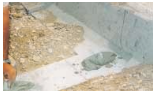
Preparación de la superficie de asiento de los módulos con mortero
