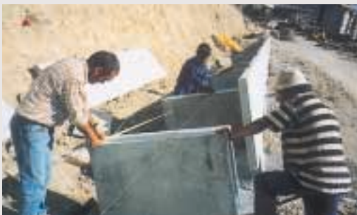
Comprobación de ejes de pedestales
