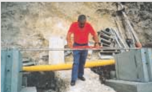
Nivelado de pedestales
