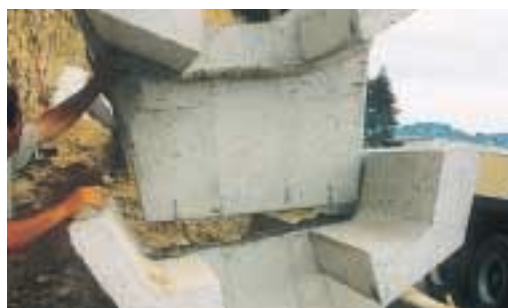
Colocación de módulos
