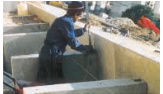
Hormigonado entre pedestales y zócalo
