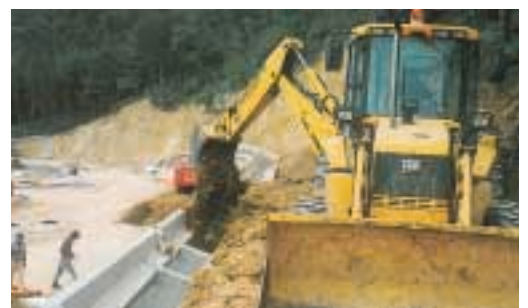
Relleno de muro desde el trasdós del mismo
