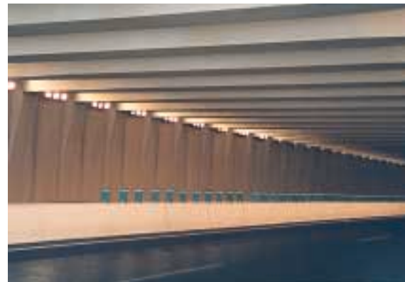
ESTIBOS CON MÉSULA SIN CARGADERO (permite acortar la longitud de las vigas)
