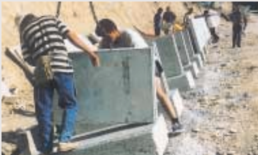
Colocado de pedestales y zócalos
