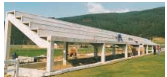
Gradas sobre estructura de hormigón prefabricado en SARON (CANTABRIA)
