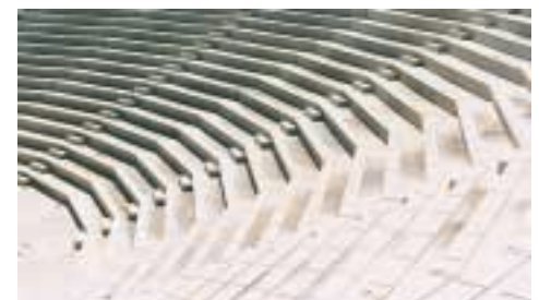
Detalle de graderio con peldaños
