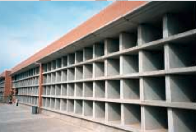
LOSAS DE CUBIERTA PARA NICHOS NV
