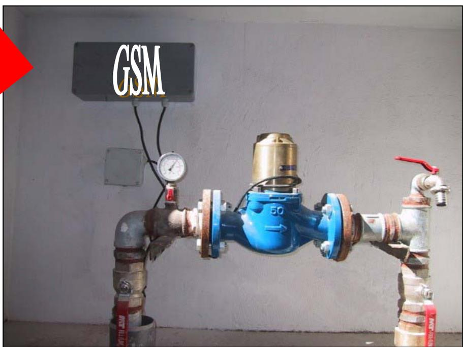
**Instalación de un contador inteligente de gran caudal que transmite la información a través de un Equipo GSM alimentado por electricidad.**
