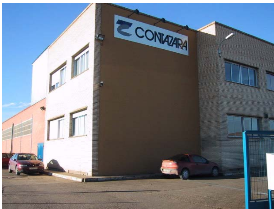
Nuevas instalaciones de CONTAZARA en Zaragoza
