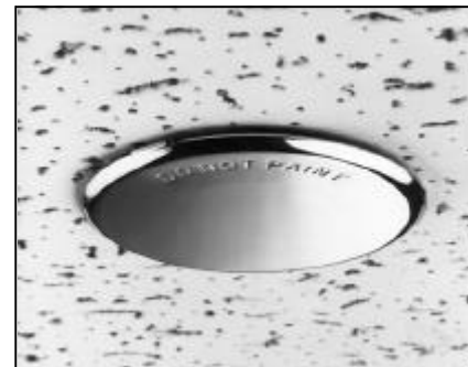
Horizon® Mirage® Oculto, instalado en falso techo acústico
