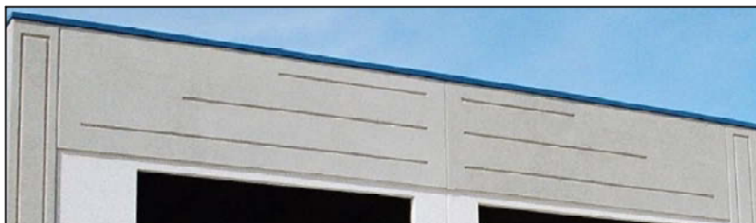
Detalle de paneles prefabricados con rehundidos. Árido "negro".
