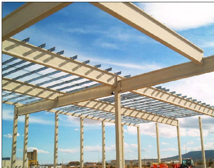
Cubierta formada con vigas I y viga salvapilar en vanos centrales.
