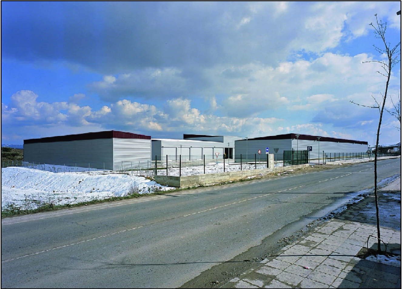
Centro de Conservación de carreteras. Autovia de Pamplona Logroño. Estella(Navarra).
