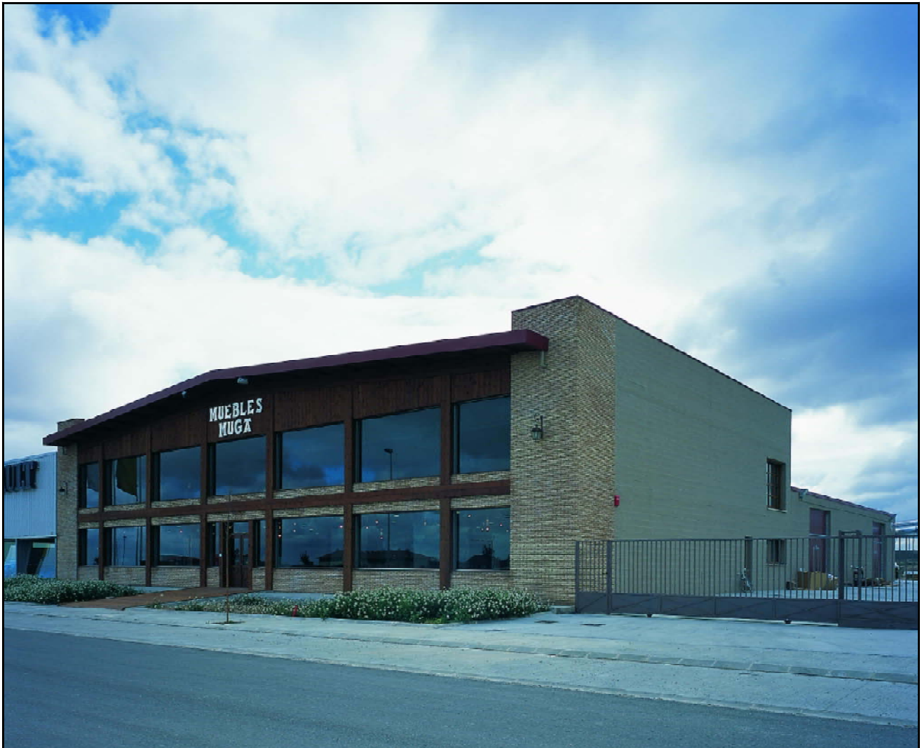
Fachada principal de Nave para Muebles Muga. Cintruénigo (Navarra).
