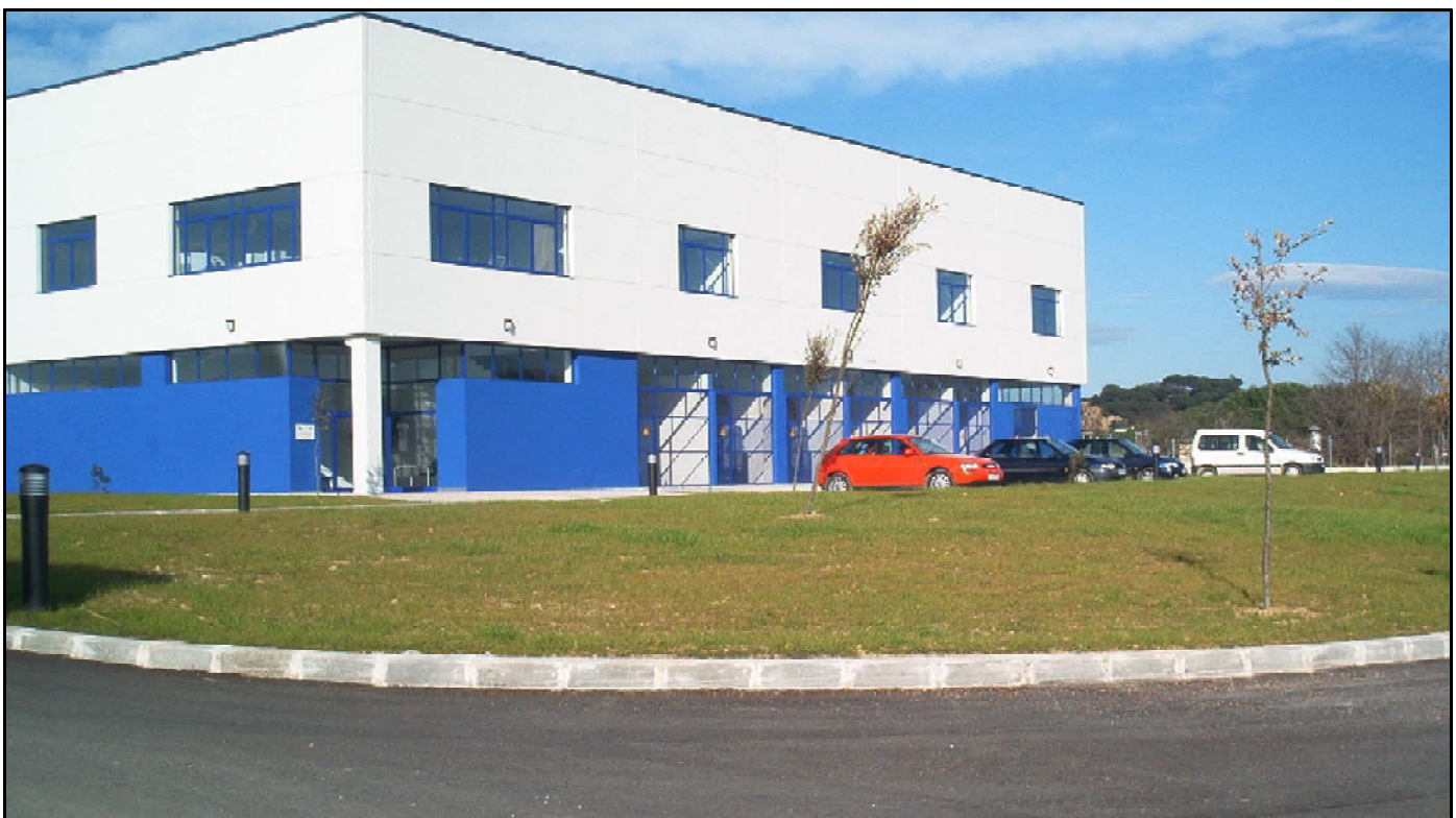
Edificio Industrial para Desaladora. Tordera (Girona)
