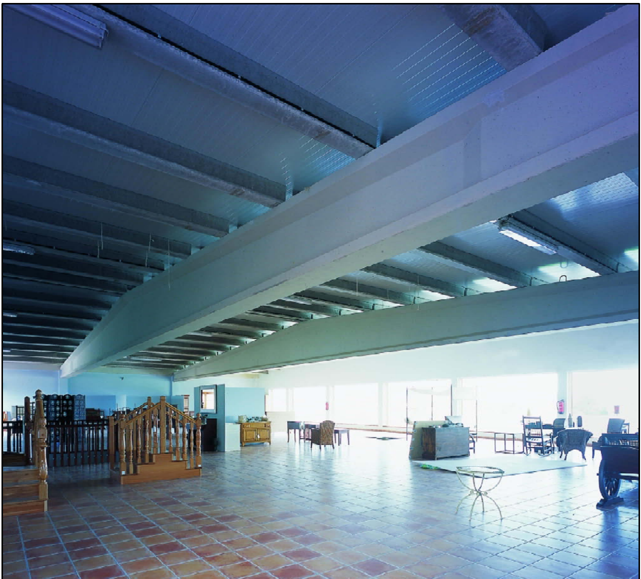
Vista interior de Nave para Muebles Muga. Cintruénigo (Navarra).
