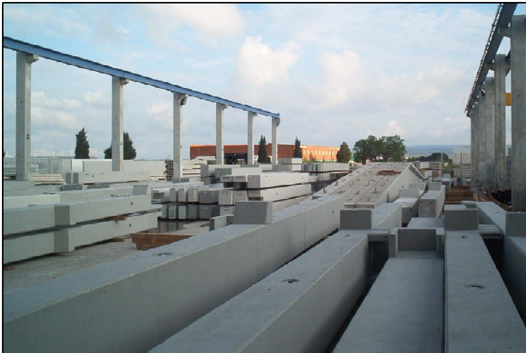
Vista desde el interior de la fábrica de la zona de acopio de vigas y pilares.
