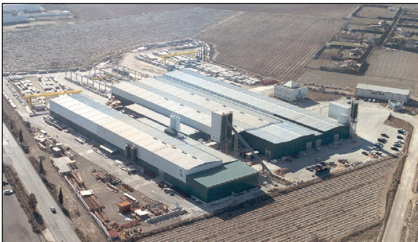
Vista aérea de las instalaciones en Corella (Navarra)
