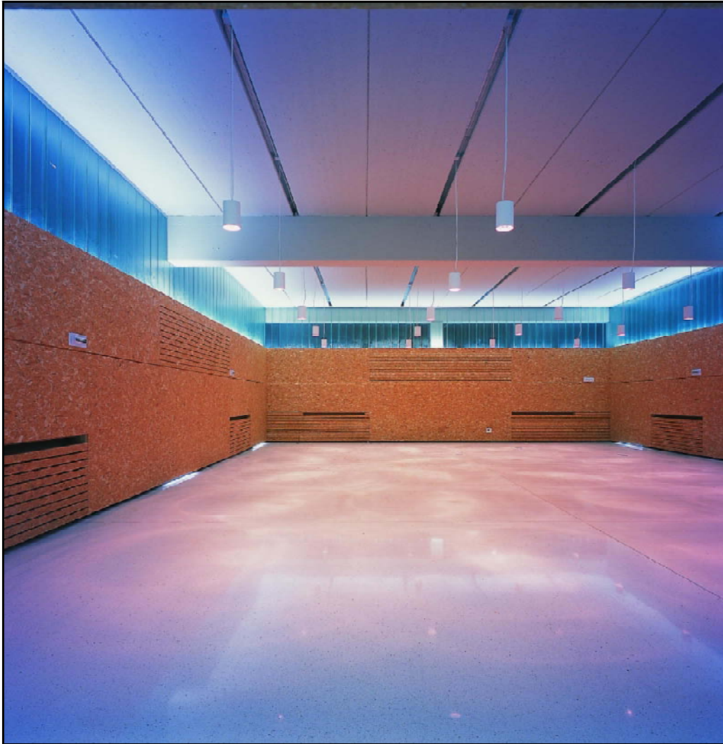
Vista Interior del Edificio para el Instituto Técnico de Gestión Agrícola. Cadreita (Navarra). Obsérvese el hueco entre losas de forjado de cubierta para paso de instalaciones.
