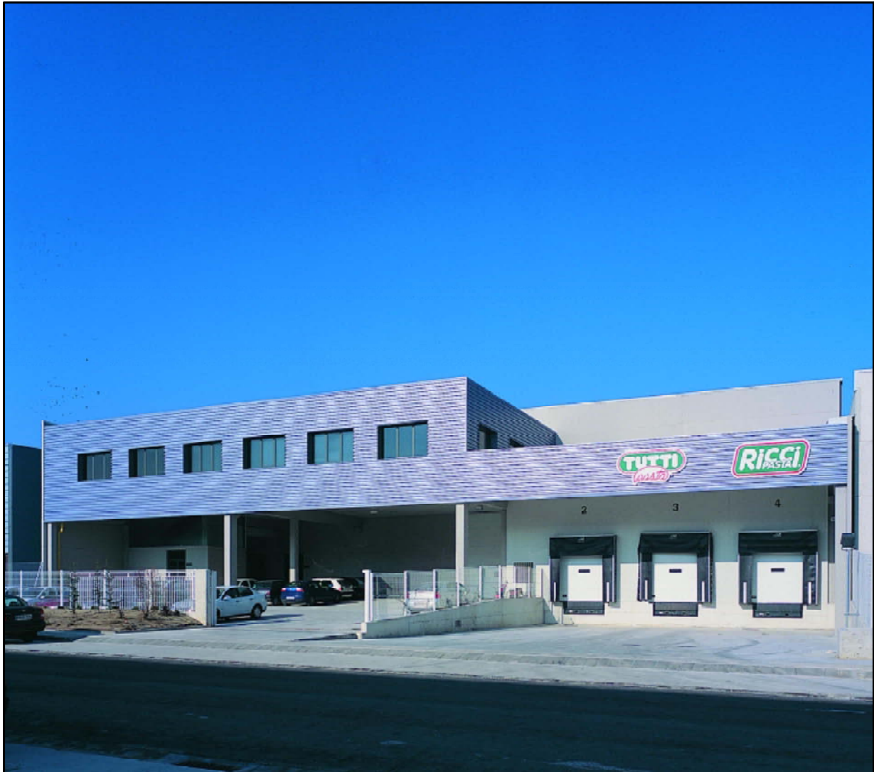
Fachada principal de Nave para TUTTI PASTA. Ezquiroz-Galar (Navarra).
