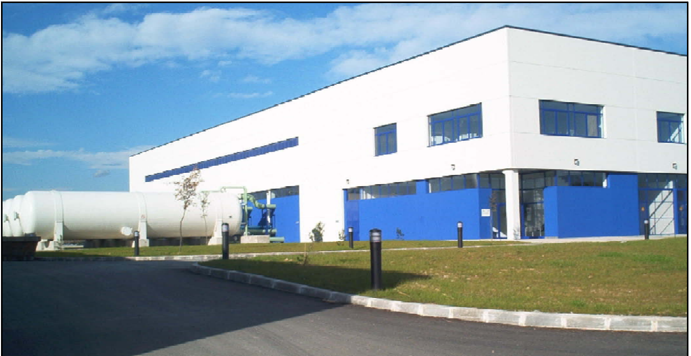
Edificio Industrial para Desaladora. Tordera (Girona)
