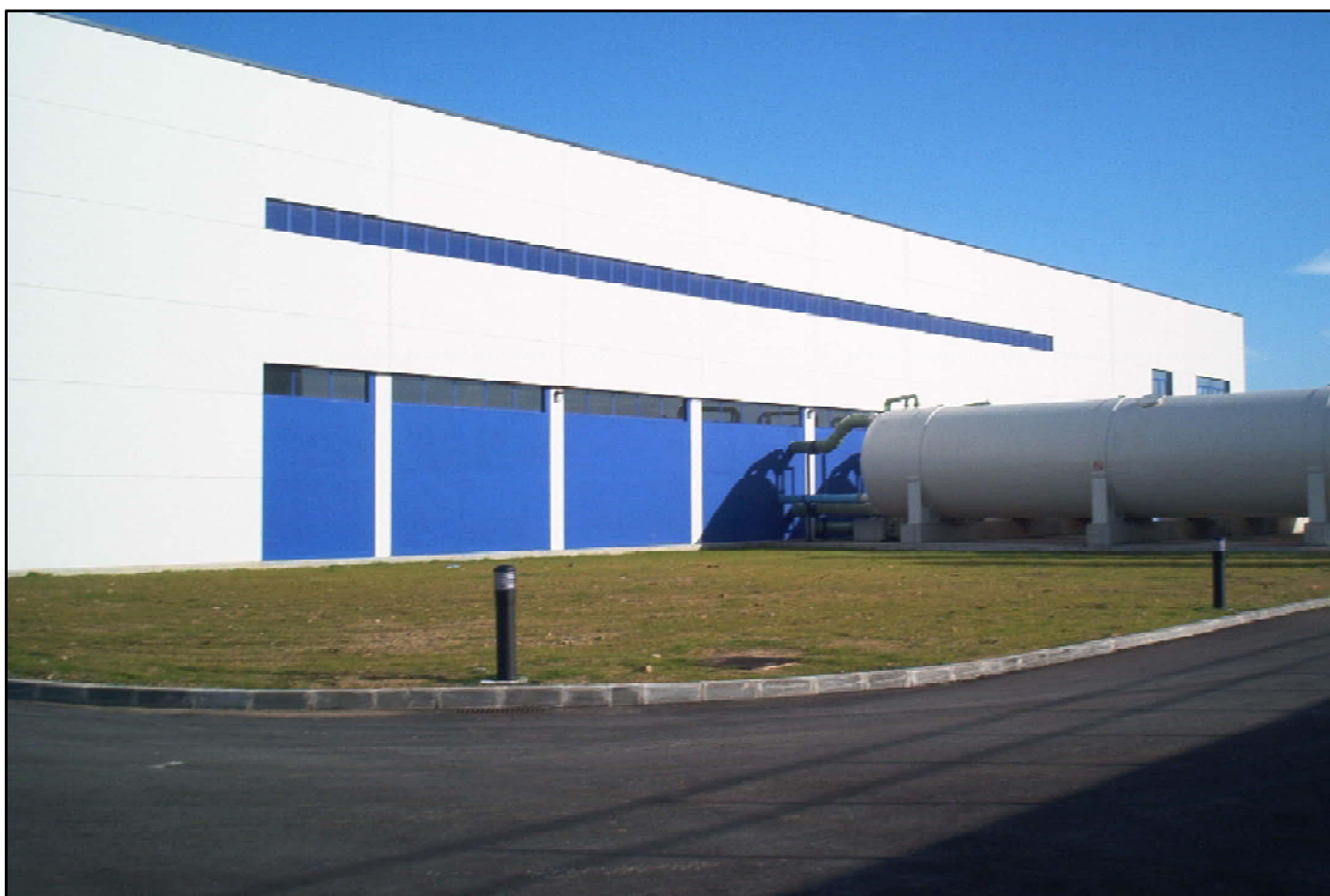
Edificio Industrial para Desaladora. Tordera (Girona)
