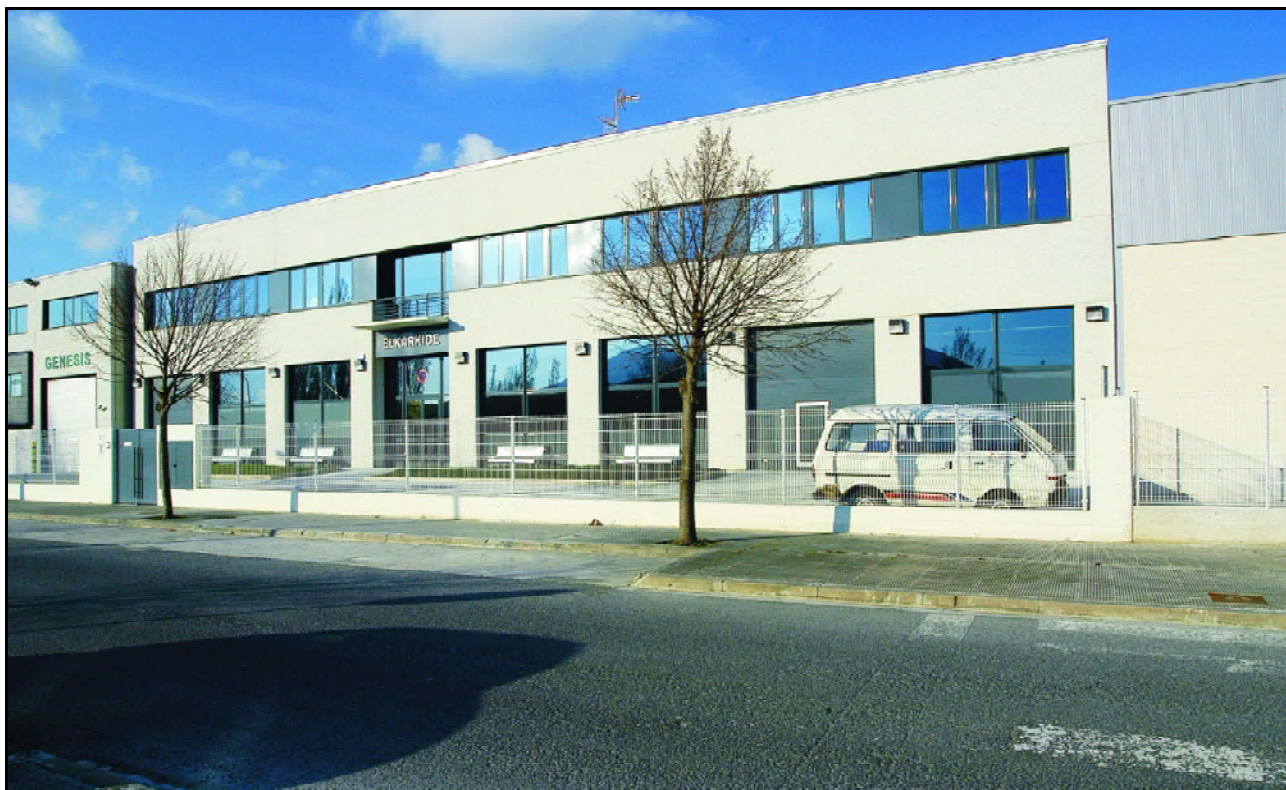
Fachada principal del Pabellon Elkarkide. Noain (Navarra).
