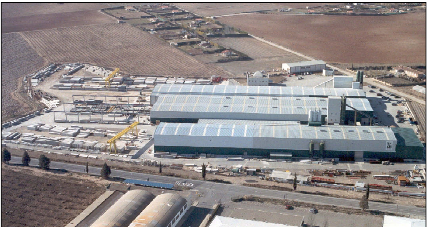
Vista aérea de las instalaciones en Corella (Navarra)
