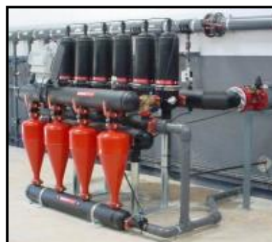
Posibilidad de control del caudal en hidrociclón mediante válvulas en Equipos de Filtrado
