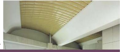
Este nuevo tipo de cubierta de hormigón pretensado se sitúa en la gama alta en términos de calidad en el ámbito de las cubiertas de edificios prefabricados. En el transcurso de estos años la tecnología ha permitido que el hormigón, gracias a nuestros técnicos, sea considerado un producto muy apreciado por sus calidades estéticas y de resistencia. En este contexto se ha creado la cubierta Variant.
