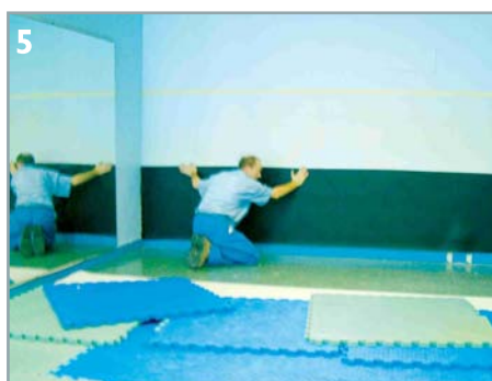
5 Colocación Positioning Mise en place
