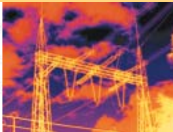
Inspección en líneas de alta tensión
