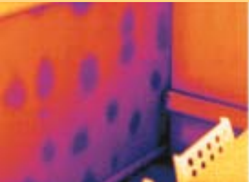
Humedades en muros
