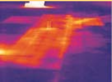
Goteras en tejados
