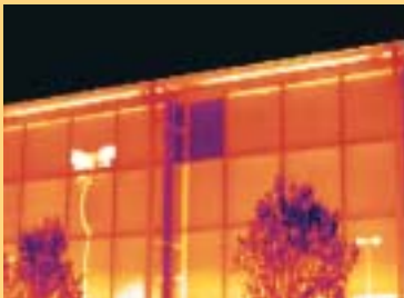
Ventanas de panel sencillo entre ventanas con paneles dobles
