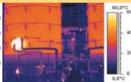
Defectos en aislamientos
