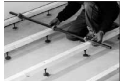
3. Dar vuelta a las viga y alinearlas a una distancia de 500 mm 4. Nivelar las vigas en altura con las patas ajustables 5. Colocar o fijar el suelo
