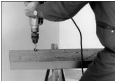
1. Preparación de las vigas
