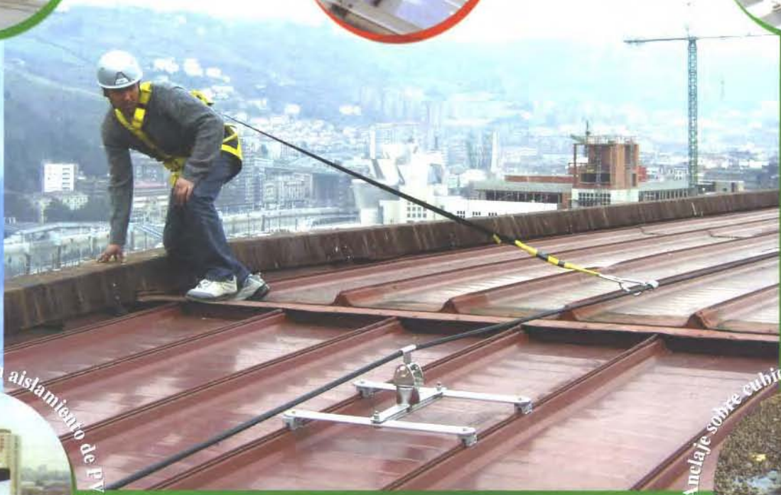
Anclaje sobre cubierta con fijación oculta
