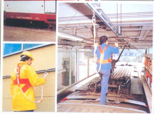
Protección contra caídas en los lugares de trabajos elevados.
