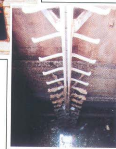
Protección de ascensión en pozos y galerías.
