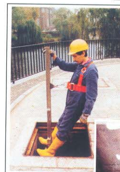
Protección de ascensión en pozos y galerías.
