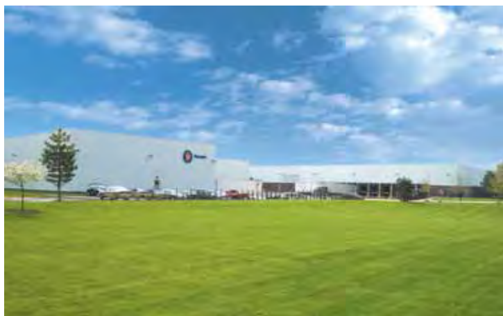
• Permatex en Solón, Ohio. Centro Técnico, Planta de fabricación y Distribución
