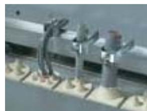
**Boquillas para la entrada de cables** (hasta 47 mm Ø) en combinación con las chapas de entrada de cables: rapidez y estanqueidad.
