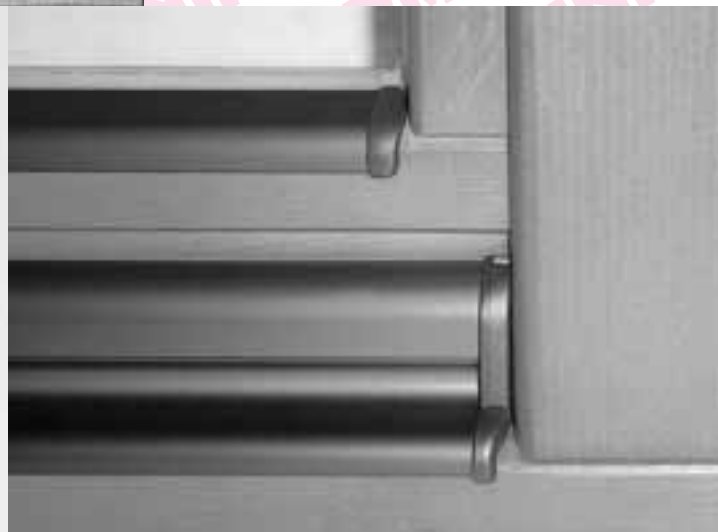
Il terminale avvolge il profilo in alluminio e lascia libera la possibilità di realizzare geometrie diverse sul profilo dei montanti in legno.
