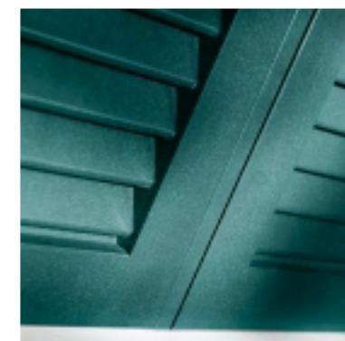
**I** Persiana in alluminio da 45 mm con angoli saldati, da 31 mm con angoli assemblati meccanicamente e lamelle ovaline fisse da 10x50 mm. Distanziate passo 40 mm. La lamella fissa distanziata a forma di ovalina arrotondata, consente una illuminazione soffusa degli ambienti e una efficace ventilazione. Questa persiana è diffusa su tutta la penisola.
