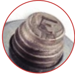
Indicador de profundidad marcado en la cabeza del tornillo.
