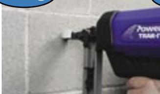
2. Fijación rápida con Trak-It
