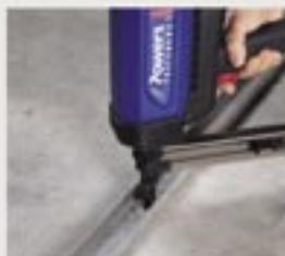
Fijación de la estructura para montaje de placas de yeso.
