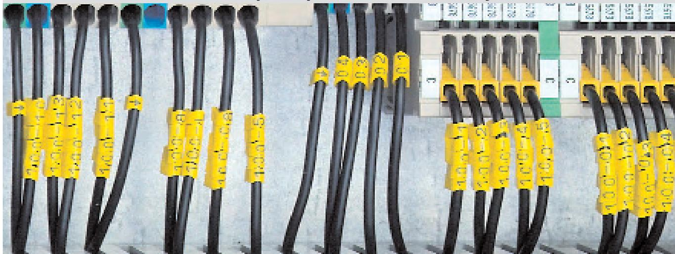
El programa de productos CableLine se compone de marcadores individuales para cables y conductores con secciones de 0,2 mm<sup>2</sup> hasta 70 mm<sup>2</sup>. Con ello el marcado de dispositivos eléctricos resulta tan sencillo como flexible. Porque en el surtido de CableLine no sólo hay marcadores abiertos, sino también cerrados, que se pueden colocar tanto antes como después de la conexión del conductor o del cable.
