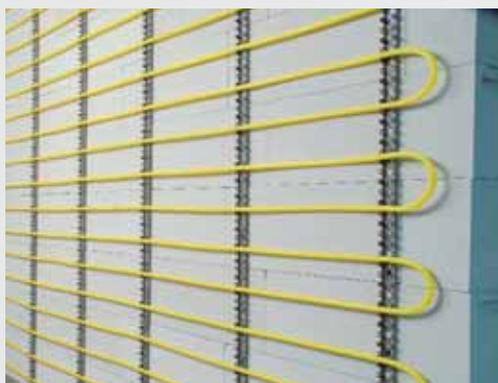
La calefacción de pared se aplica a menudo en lugares donde la calefacción por suelo radiante por condiciones constructivas no es posible, o cuando la calefacción por suelo radiante no es superficie para la calefacción de una sala. Con divisiones parciales de la calefacción por pared, por ej. en un baño, se pueden crear áreas confortables y se puede prescindir de radiadores adicionales.
