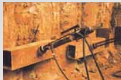
Anclaje de terrenos - Ground anchors
