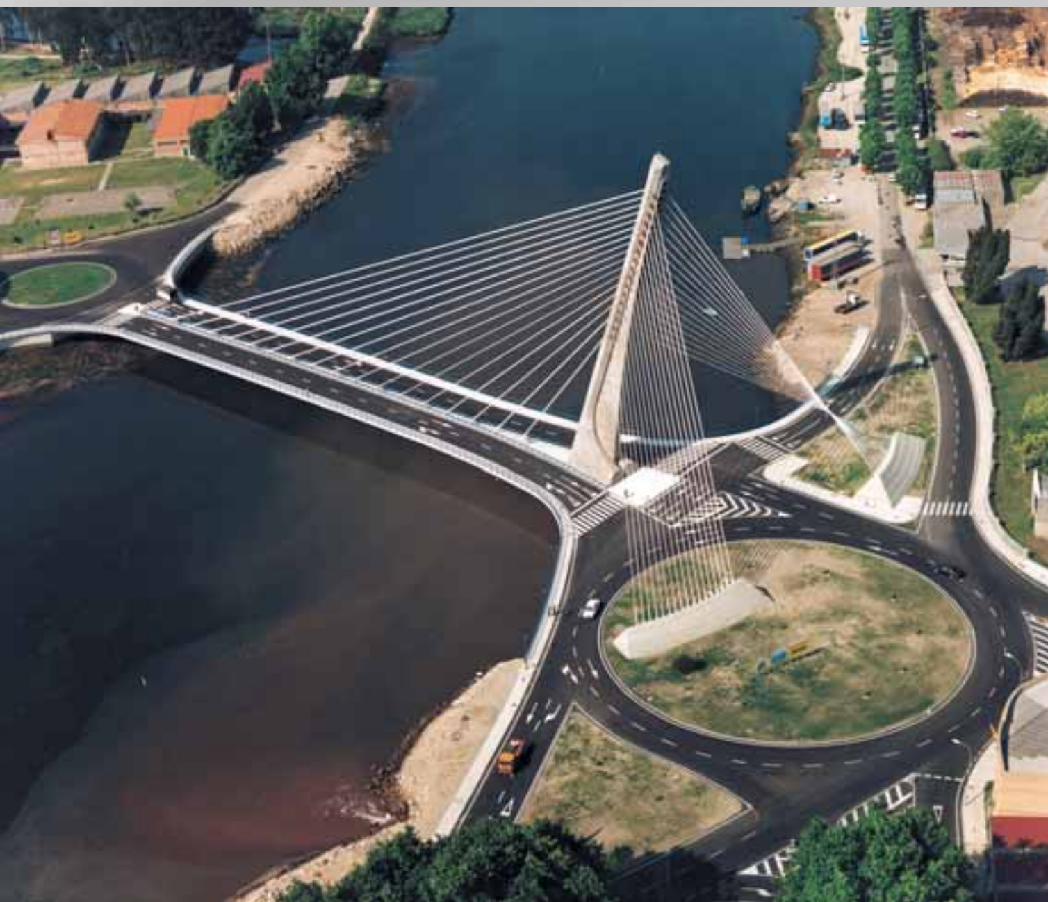
Puente sobre el río Lerez (Spain)
