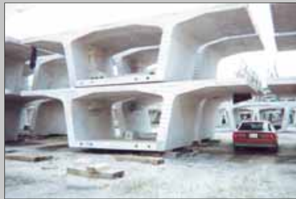
Secciones de puentes pretensados · Prestressed Bridge Sections
