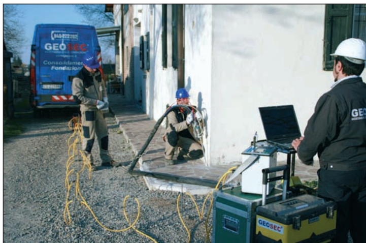
[Figura 4].- A la derecha un geólogo mide la resistividad eléctrica del terreno utilizando un georesistivímetro, mientras que a la izquierda un equipo operativo ejecuta la inyección de resina bajo la casa.
