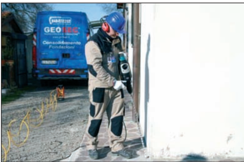
■ [Fig. 1] .- Perforación de inyección (Ø 2mm).
