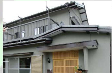
Shizuoka Zona pintada: paredes/techo – sobre 40m 2 ; fachada exterior – sobre: 260m 2
