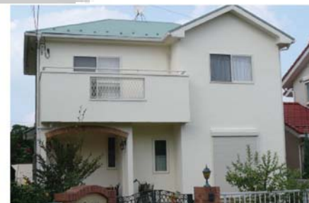
Ibaraki Zona pintada: techo - 94m 2 ; Fachada Exterior - cerca de 140m 2 .
