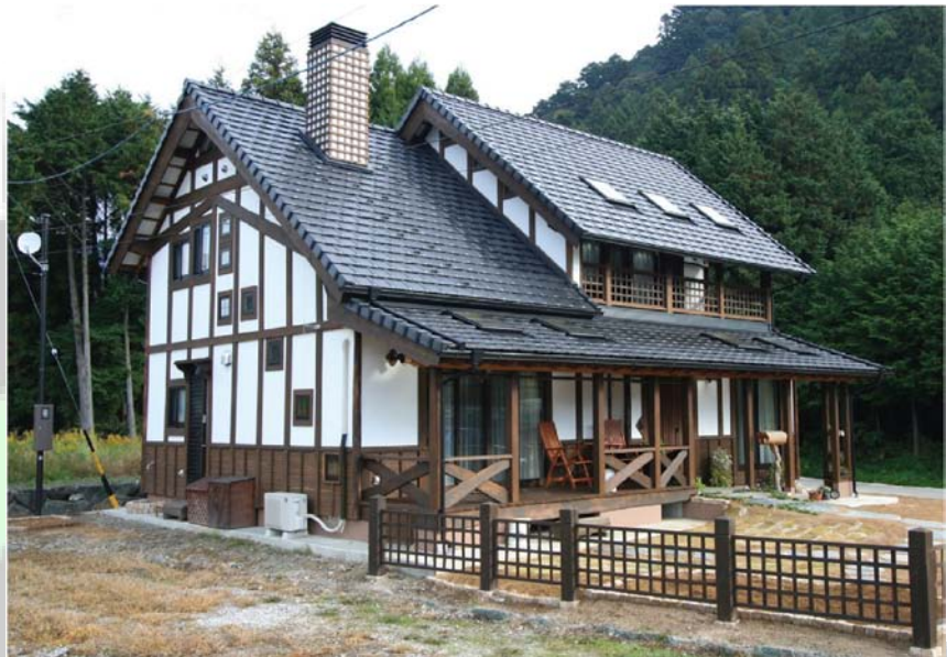
Zona pintada: paredes / techos - cerca de 415m 2 (4,467 pies cuadrados); Techo (tejado impermeable) - cerca de 160m 2 (1.722 pies cuadrados); Fachada Exterior - cerca de 175m 2 (1.884 pies cuadrados.)
