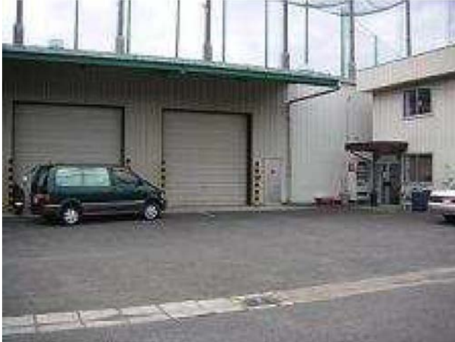
Entorno del almacén
