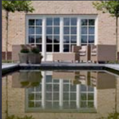
Ventanas y puertas en PVC
