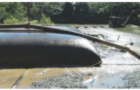
Os tubos geotêxteis permitem o escoamento do líquido através dos poros do geotêxtil, retendo as partículas sólidas floculadas, reduzindo o teor de umidade e devolvendo a parte líquida novamente para o tanque, lagoa, etc.
