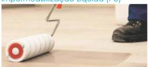
A aplicação do sistema líquido de Poliuretano é feita em multicamadas, podendo ser aplicado em diversas superfícies de concreto expostas ao tráfego de pedestres e tráfego de veículos leves e pesados. Ideal para plataformas de estacionamento, pois não necessita ser coberto com asfalto e resiste à tração dos pneus.
