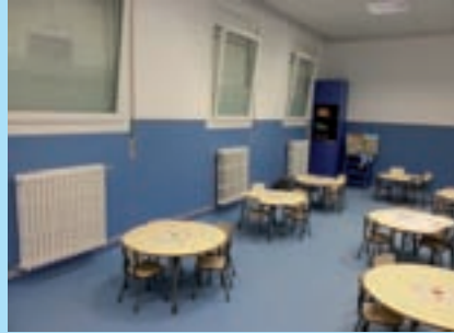
Paviment Vinílic Tarkett Micra en terra i arrambadors
