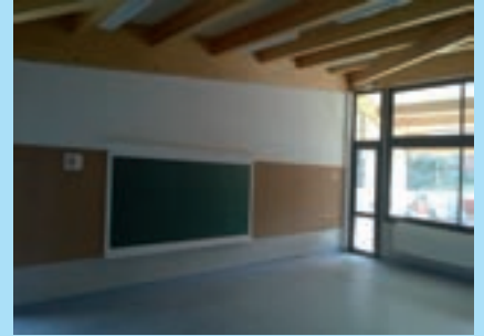
Paviment Vinílic Tarkett Eclipse i Granit i parets amb suro industrial
