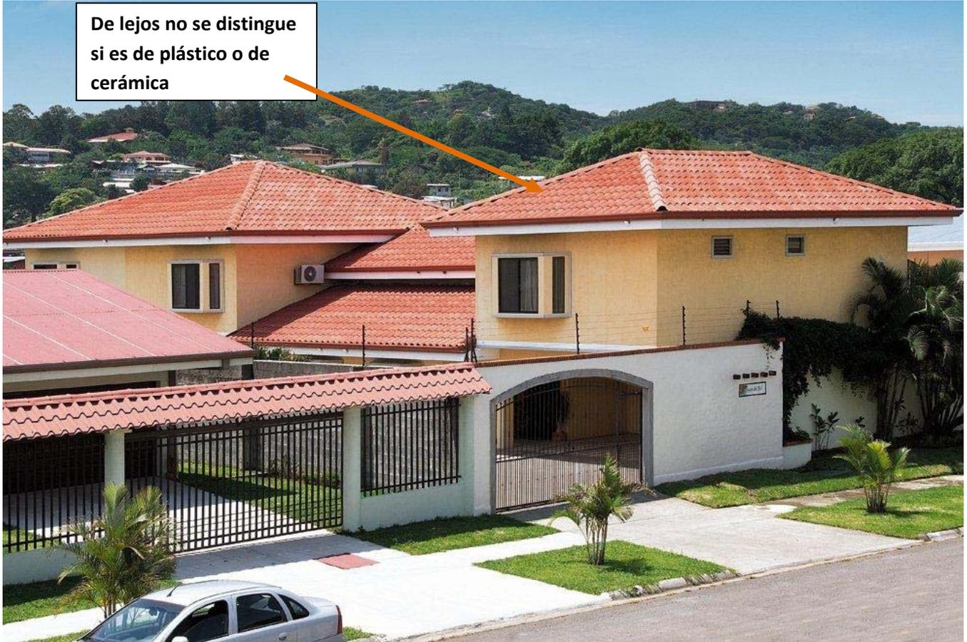
En esta fotografía se aprecia a la izquierda teja y paneles de chapa y a la derecha teja plástica que de largo se aprecia como teja tradicional individual.
